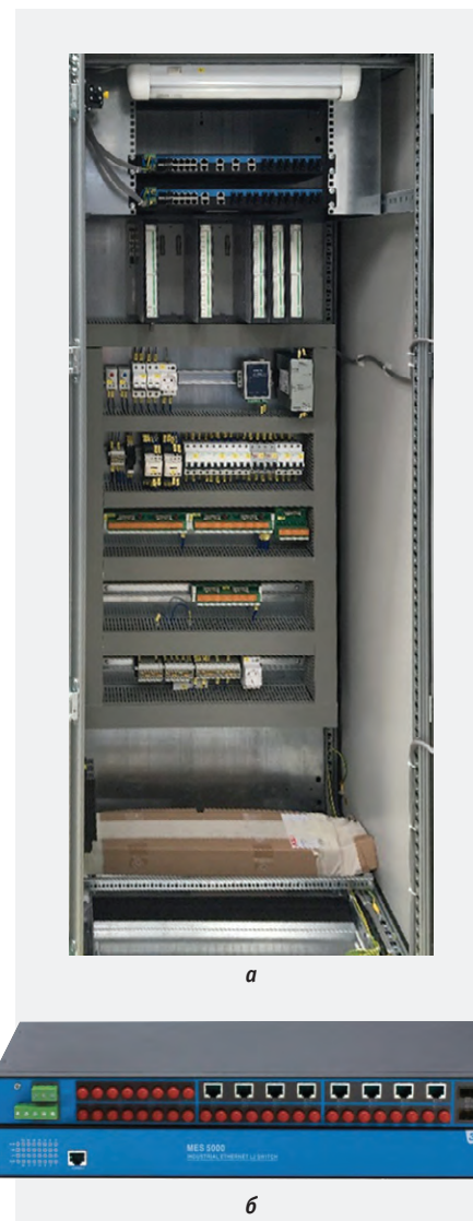
Рис. 4. Коммутатор Zonedata MES5000 для применения на объектах энергетики: внешний вид (а); инсталляция на объекте (б)
