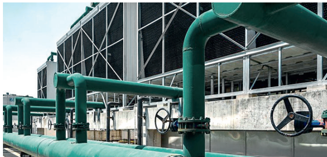
Рис. 5. Около 200 локальных систем управления водоснабжением города Сианя оборудованы сетевыми коммутаторами и интеллектуальными шлюзами данных Advantech
