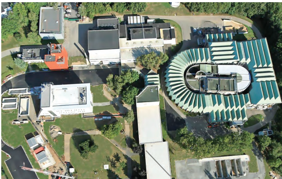
Рис. 9. Общий вид комплекса зданий испытательного центра CSTB в г. Нанте
