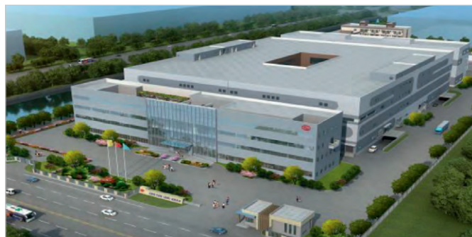
Рис. 2. Новое предприятие по производству Al E-Cap в Хучжоу
